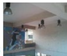
現場實地勘察(照明)
