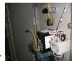
現場實地勘察(設備)
